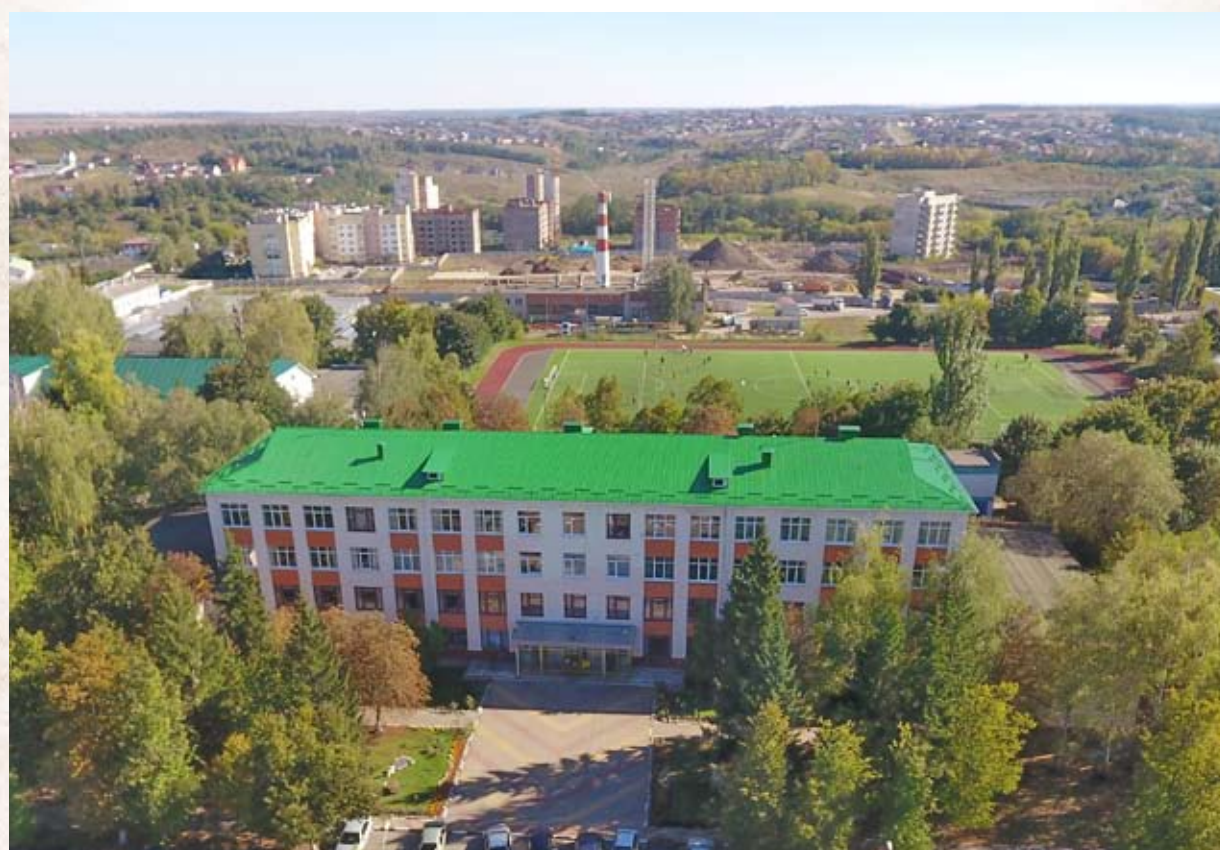
Здание технологического факультета (площадь 4423 м 2 ), п. Майский, ул. Вавилова, 24
