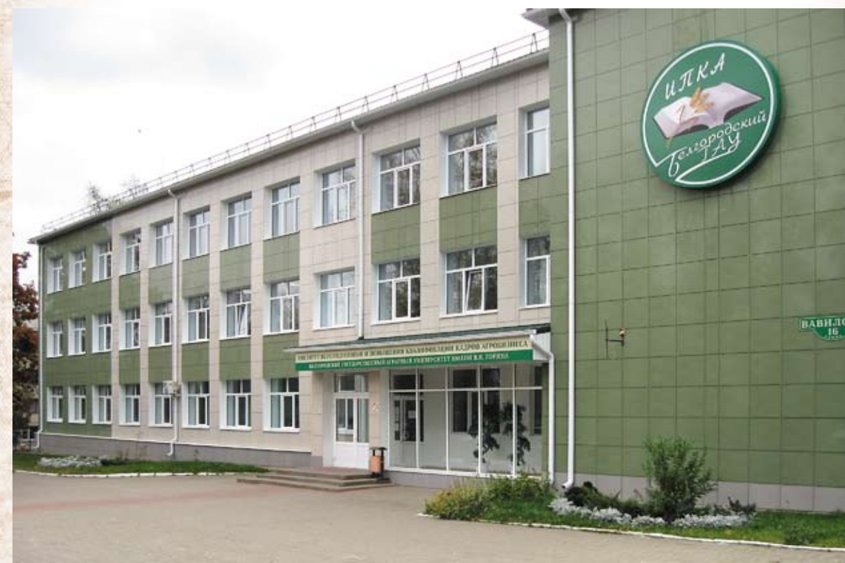
Здание учебно-лабораторного корпуса института переподготовки и повышения квалификации кадров агробизнеса (площадь 1522,5 м 2 ), п. Майский, ул. Вавилова, 16
