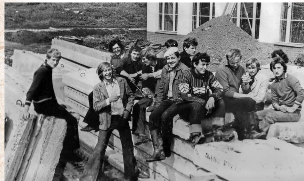
Первые студенты филиала на строительстве спортивного зала. Белгородский филиал Воронежского СХИ им. К. Д. Глинки
