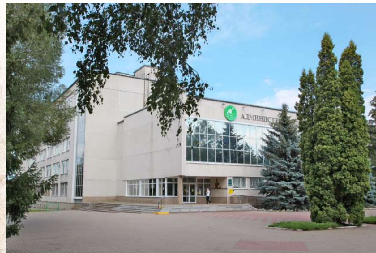
Здание учебно-административного корпуса (площадь 6765,3 м 2 ), п. Майский, ул. Вавилова, 1
