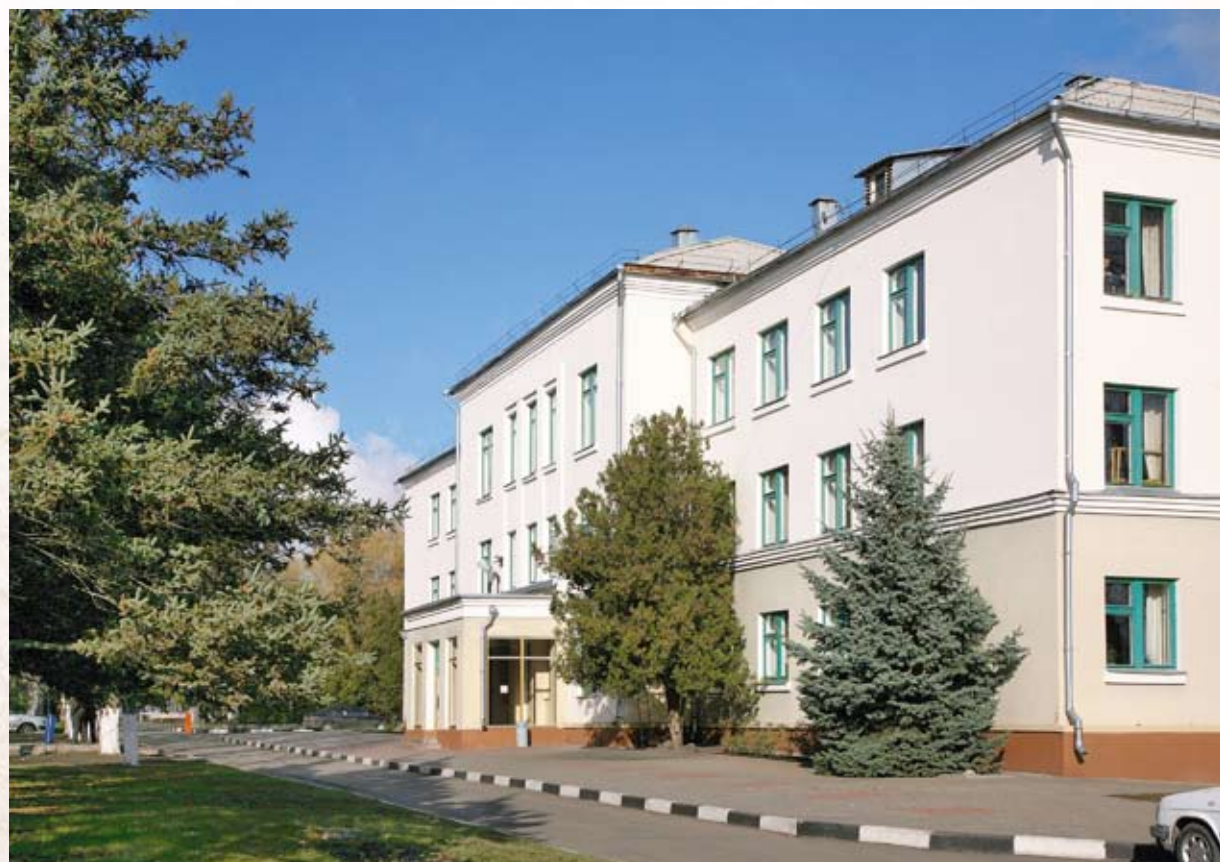
Здание инженерного факультета (площадь 3188,9 м 2 ), п. Майский, ул. Вавилова, 10
