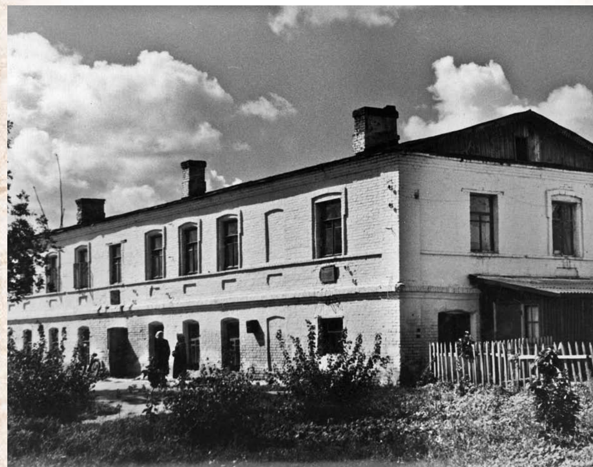
Научный корпус опытной станции. 1958 – 1962 гг.
