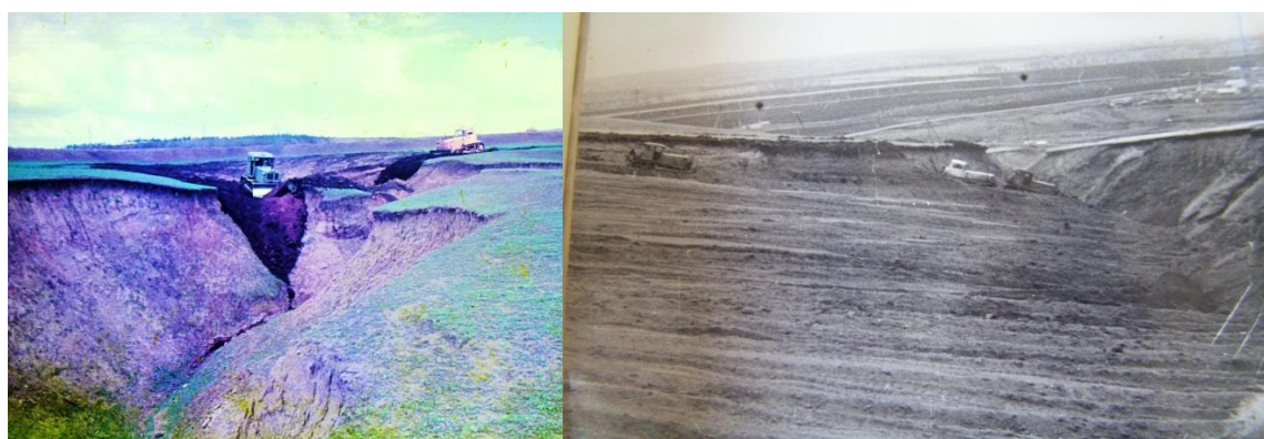
Рисунок 1;2 Выполаживание и засыпка оврагов в Туймазинском районе
