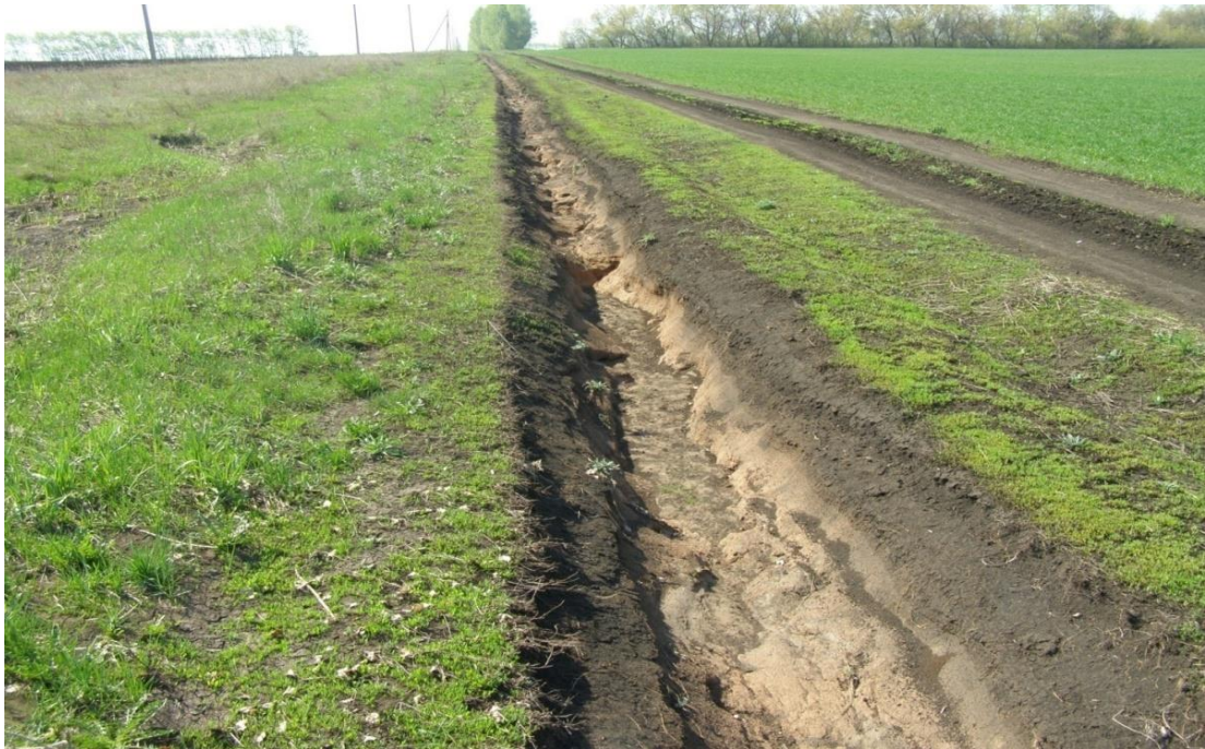
Рисунок 1 -Размыв дороги
