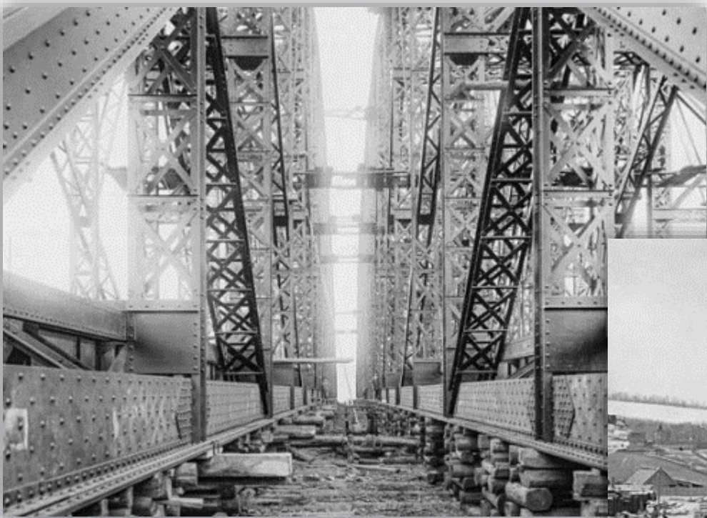
Внутри между ферм, по снятии верхних подмостей
