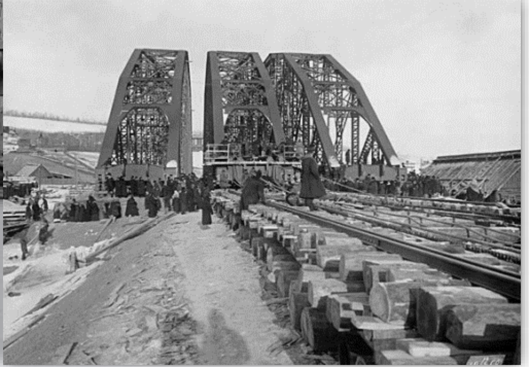
Фермы на левом берегу перед началом перекачки
